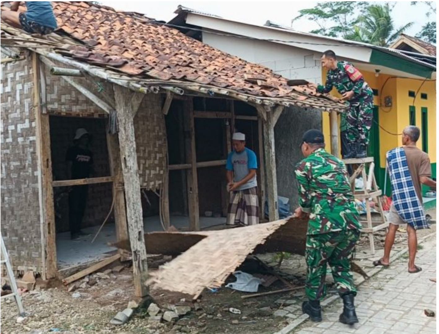
Pembongkaran Rumah Bapak Narmin
